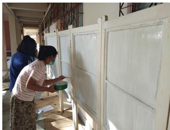
ภาพที่ 15 การทาสีโครงไม้
